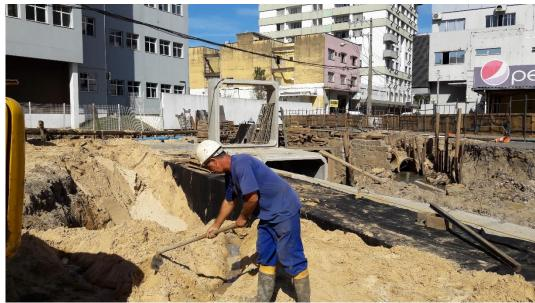
Figura 13: Fechamento das valas no canteiro de obra. (Fonte: Dos autores 2016)
