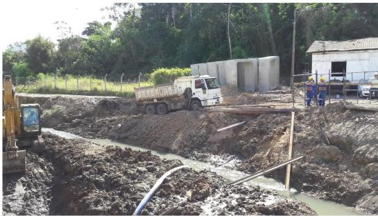
Figura 12: Despejo de material granular feito por caminhão. (Fonte: Dos autores 2016)
