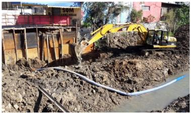
**Figura 10:** Realização do transporte de material granular para local escavado. (Fonte: Dos autores 2016)
