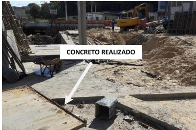
Figura 07: Concretagem realizada. (Fonte: Dos autores 2016)
