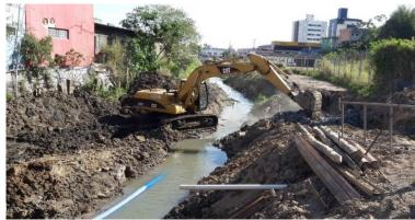
**Figura 11:** Realização do transporte de material granular para local escavado. (Fonte: Dos autores 2016)
