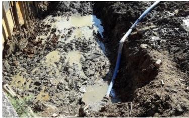
Figura 09: Remoção das águas. (Fonte: Dos autores 2016)
