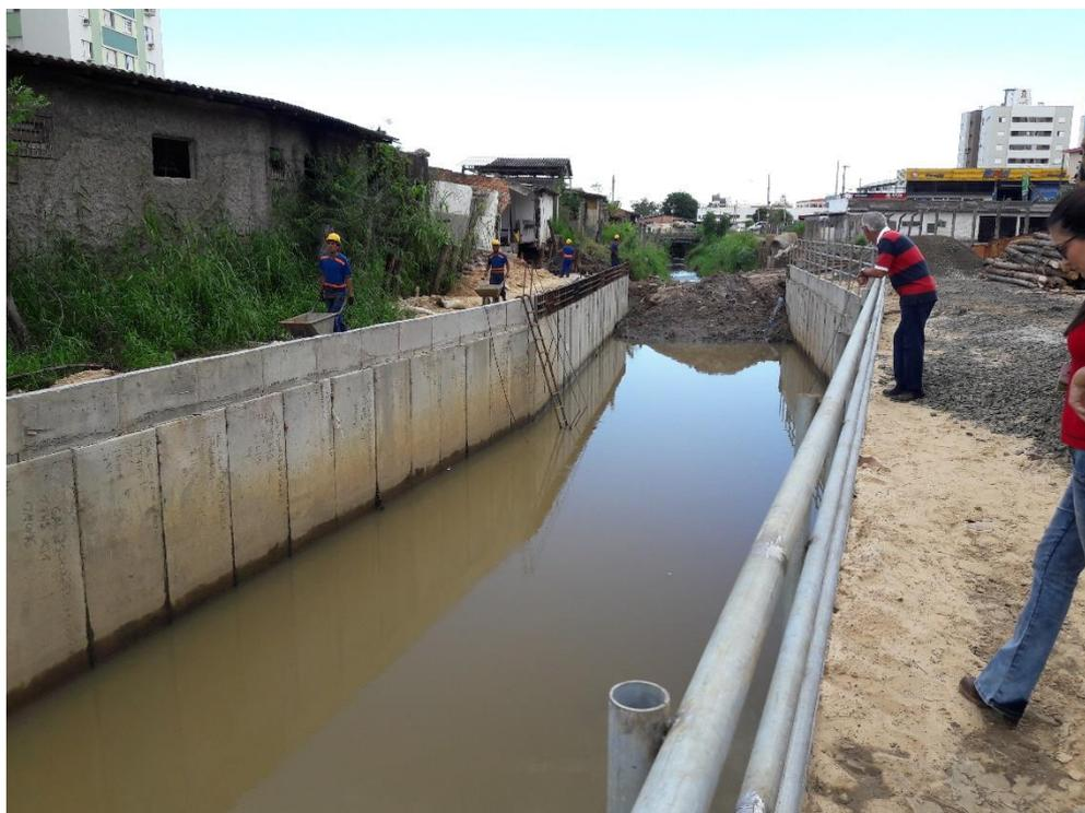
**Figura 08:** Trecho com aduelas e corrímão instalados. (Fonte: Dos autores 2017)
