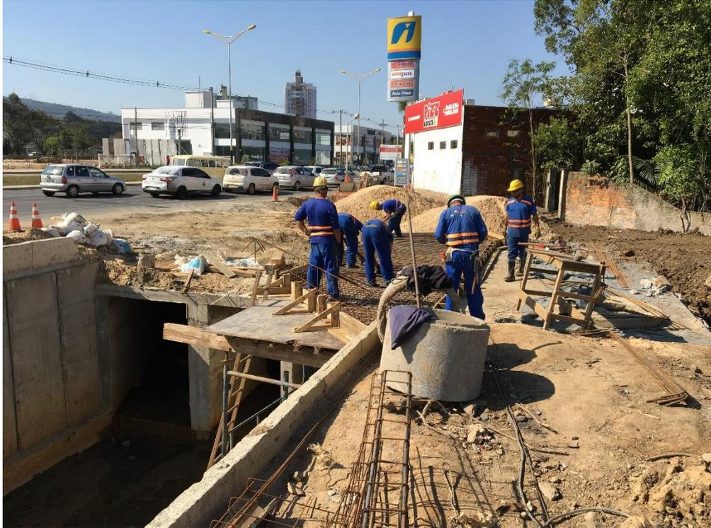
**Figura 9:** Trabalhadores executando a armação do radier. (Fonte: Dos Autores 2018)
