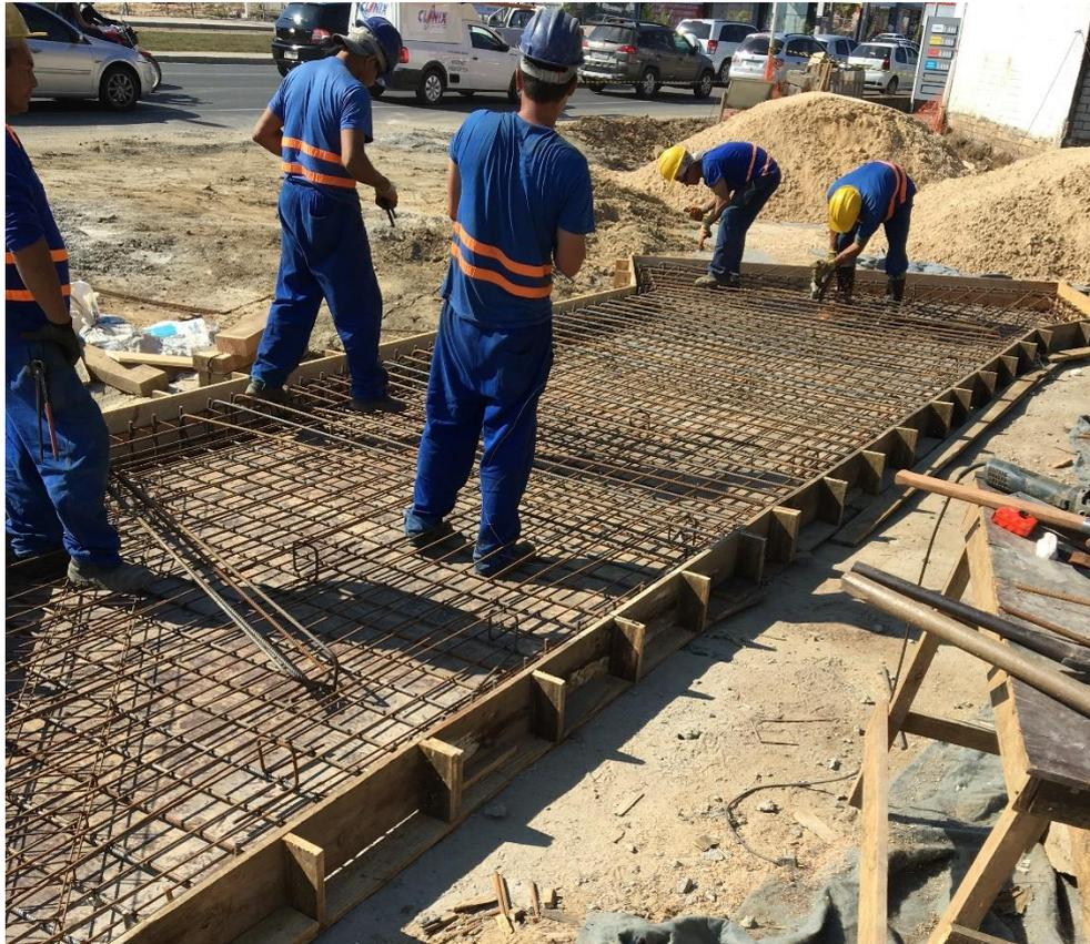
**Figura 10:** Trabalhadores executando a armação do radier. (Fonte: Dos Autores 2018)
