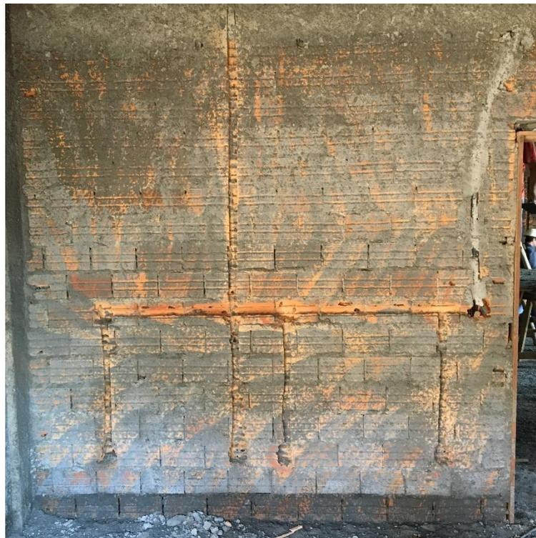
**Figura 16:** Aberturas para a instalação da rede elétrica. (Fonte: Dos Autores 2018)
