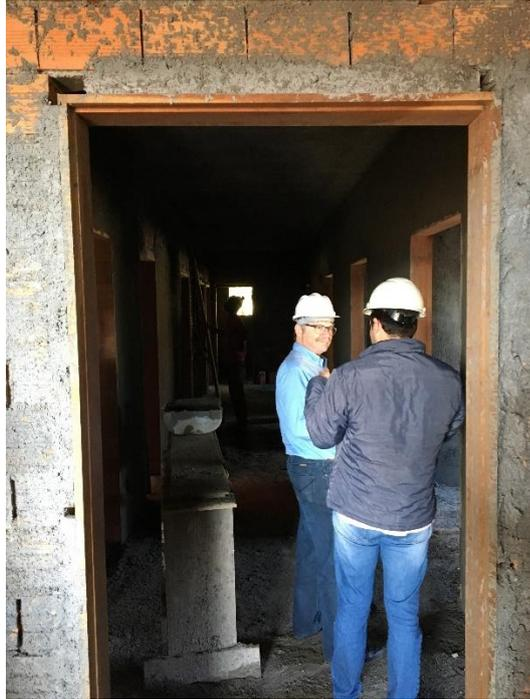
**Figura 13:** Batente para a instalação da porta. (Fonte: Dos Autores 2018)
