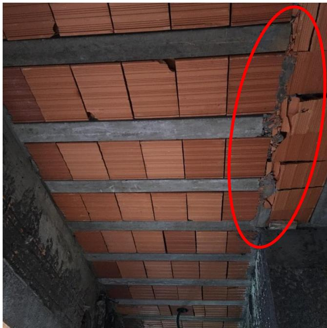
**Figura 14:** Trincas na estrutura da laje. (Fonte: Dos Autores 2018)
