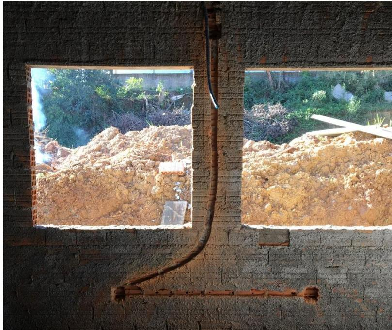
**Figura 15:** Aberturas para a instalação da rede elétrica. (Fonte: Dos Autores 2018)
