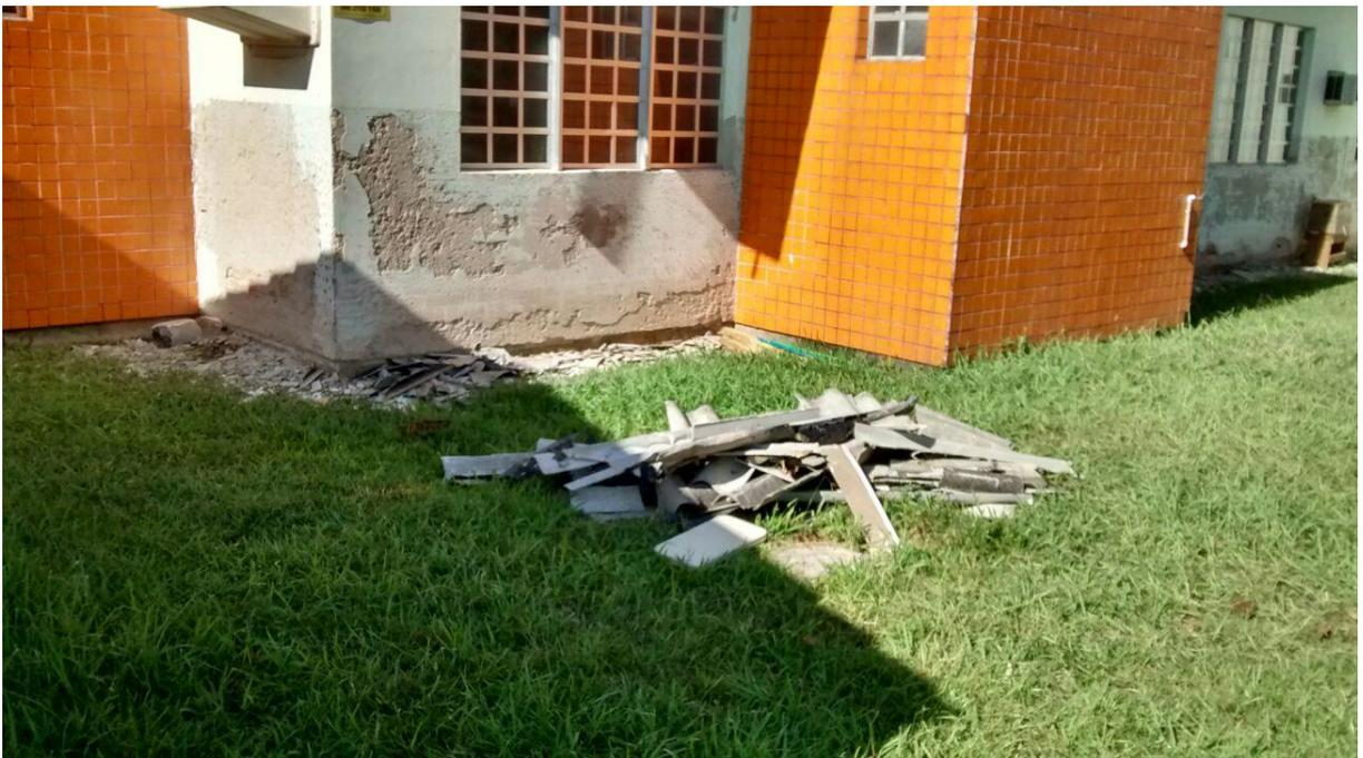
**Figura 11:** Telhas de fibrocimento antigas retiradas. (Fonte: Dos Autores 2016)
