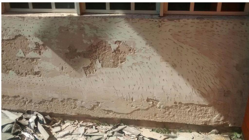
**Figura 17:** Revestimento da parede sendo retirado. (Fonte: Dos Autores 2016)
