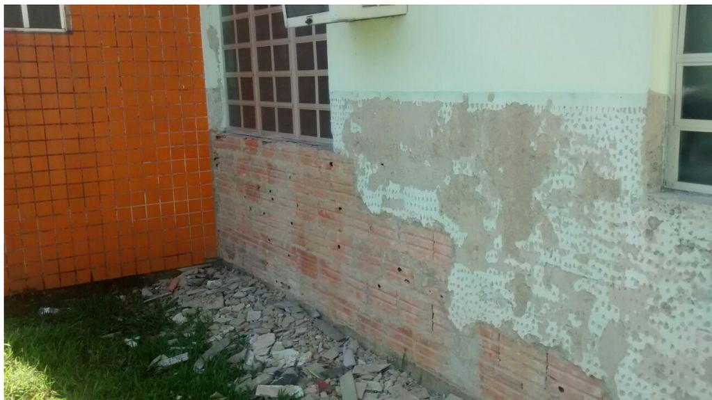
**Figura 16:** Revestimento da parede sendo retirado. (Fonte: Dos Autores 2016)
