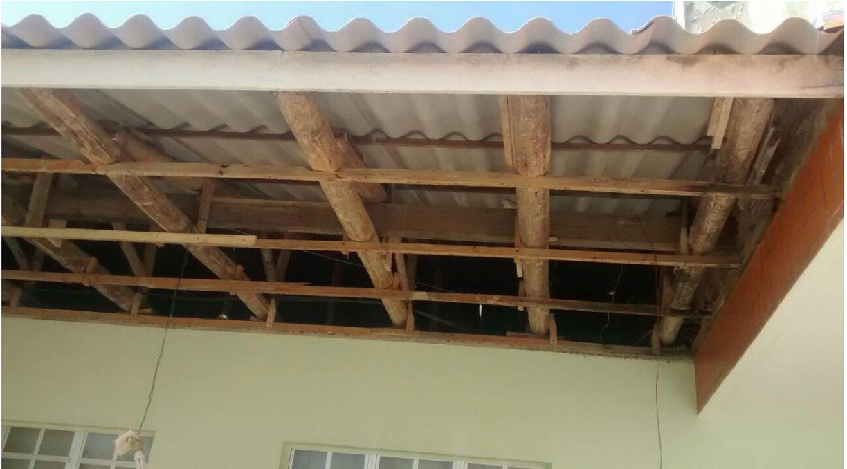
**Figura 08:** Beiral do prédio retirado. (Fonte: Dos Autores 2016)
