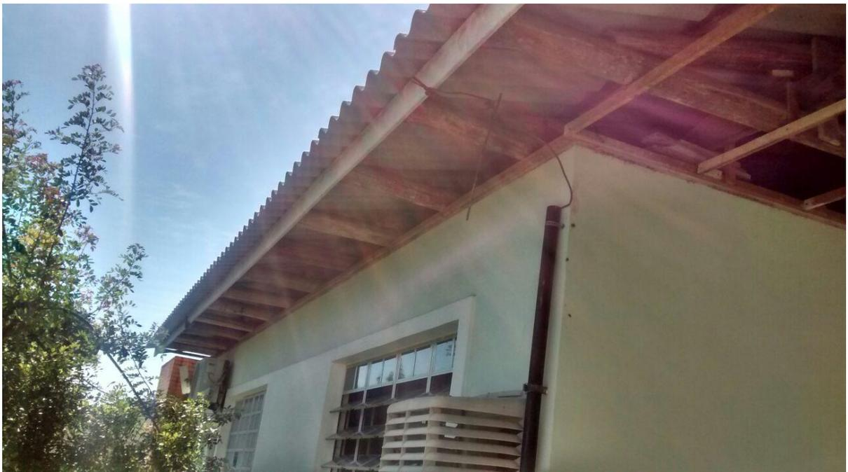
**Figura 09:** Beiral do prédio retirado. (Fonte: Dos Autores 2016)
